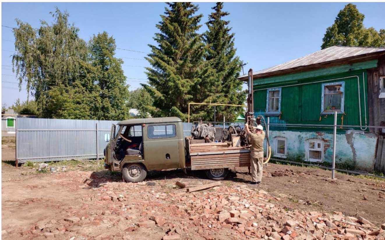
Фото 2.3. северо-восточная часть площадки, точка бурения скв. № 1
