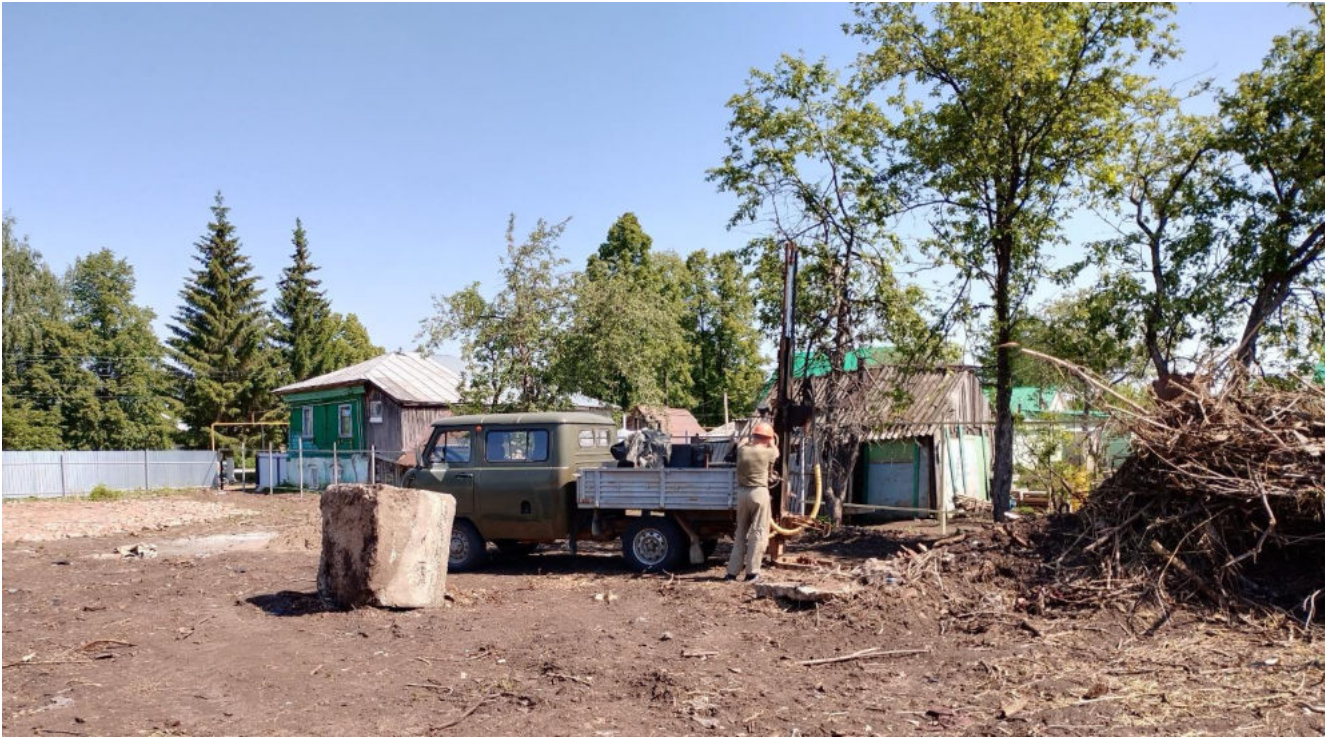
Фото 2.1. южная часть площадки, точка бурения скв. № 3
